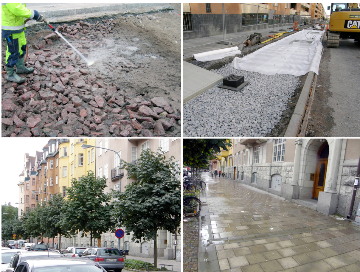
Abb. 5. Die Verfüllung der Baumrigolen erfolgt mit einer Skeletterde. Sie besteht in Schweden aus einem grobkörnigen Granit, in den ein Feinboden lagenweise mit hohem Wasserdruck eingeschwemmt wird (oben links). Die oberste Auflage bildet ein Grobschotter, über den die überdimensionalen Pflanzgruben entlüftet werden. Auf dieser Lage erfolgt der reguläre Wegebau (oben rechts). Die Anlagen können mit jeder beliebigen Baumart bepflanzt werden. Durch die hervorragenden Eigenschaften der Standorte, haben beispielsweise auch Berg-Ahorne wieder eine langfristige Perspektive im innerstädtischen Bereich (unten links). In Stockholm wird unter anderem der Dachabfluss von den Fallrohren über den Gehweg in die Pflanzgruben geleitet (unten rechts).
