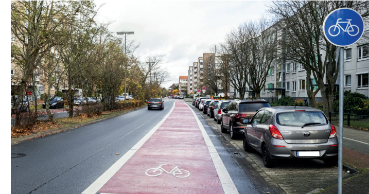
Radfahrstreifen mit durchgezogener Markierung
