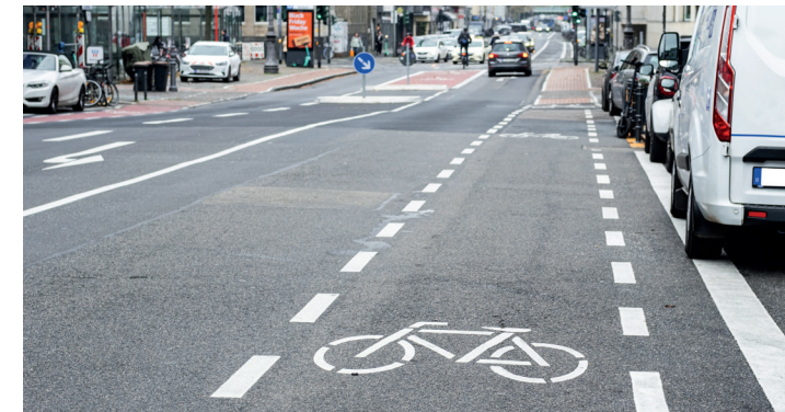
Schutzstreifen mit unterbrochener Markierung
